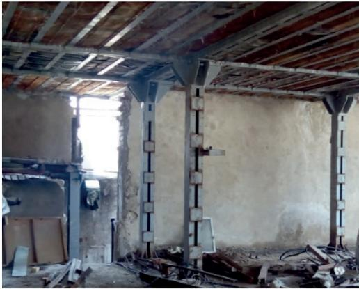
Рисунок 4 – Жесткий узел с опорными столиками в строящемся кафе, г. Бишкек
