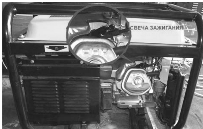
Рис. 40. Общий вид генератора на жидком топливе (увеличено место установки свечи зажигания).
