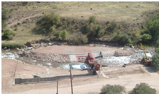
Рисунок 5.2 – Водозаборное сооружение для деривационной ГЭС, построенное в 2010 г. на р. Мерке в Меркенском районе, Джамбульской области, Казахстан
