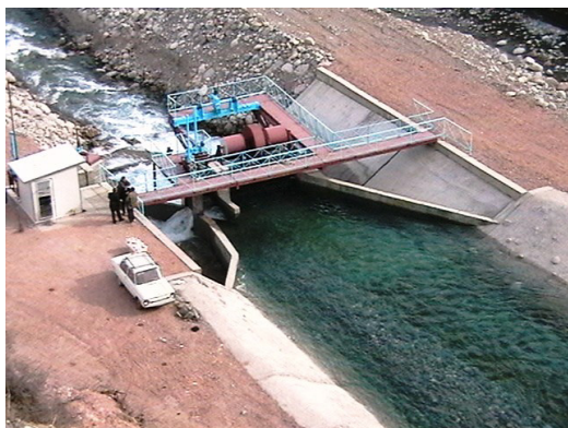
Рисунок 5.1 – Водозаборное сооружение для деривационной ГЭС, построенное в 2007 г. на р. Иссык-Ата в Чуйской области, Кыргызстан
