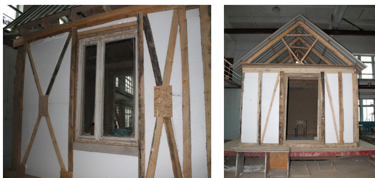
Рисунок 3 – Первоначальные этапы утепления экспериментального жилого дома
