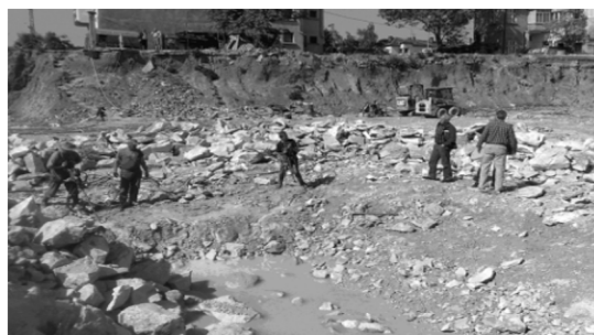
Рисунок 4 – Разрушение крепких доломитизированных известняков с коэффициентом крепости по шкале проф. М.М. Протоdjeяконова 8–10 патронами кардокс при выемке котлована для торгового центра в Болгарии
